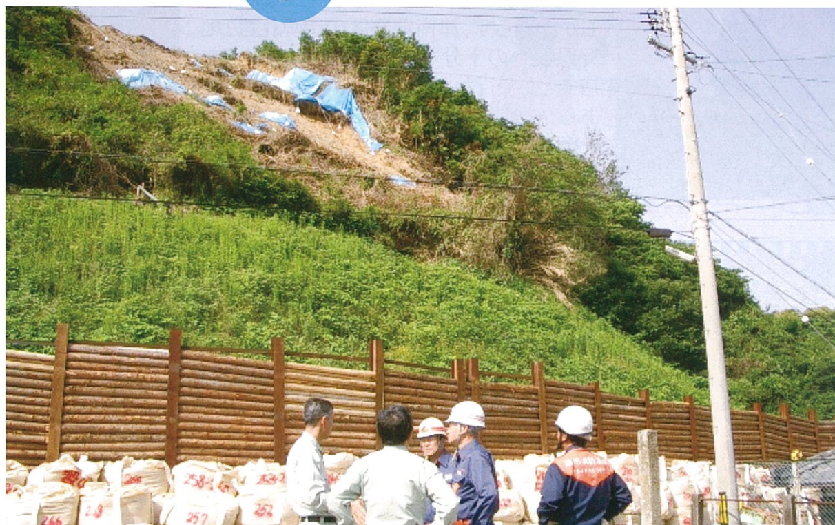
津市中村町 山腹崩壊現場
